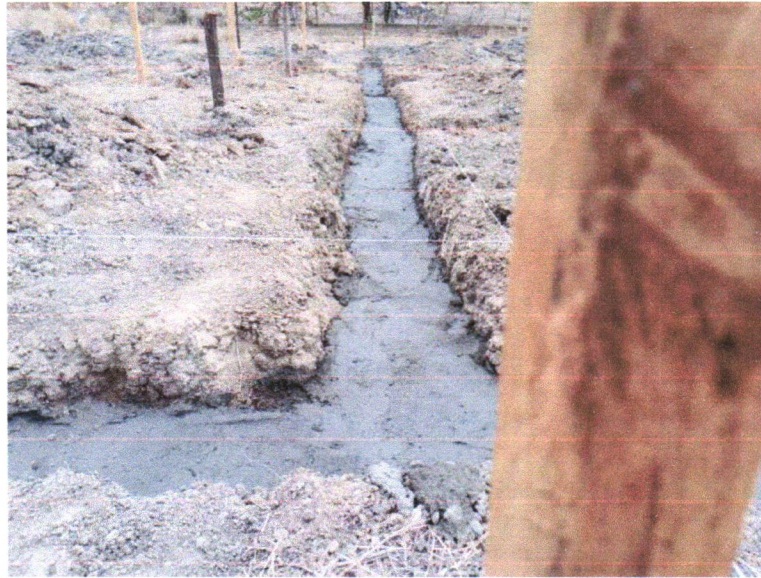
FOTO 07-LASTRO DE CONCRETO MAGRO, APLICADO EM BLOCOS DE COROAMENTO OU SAPATAS, ESPESSURA DE 3 CM
