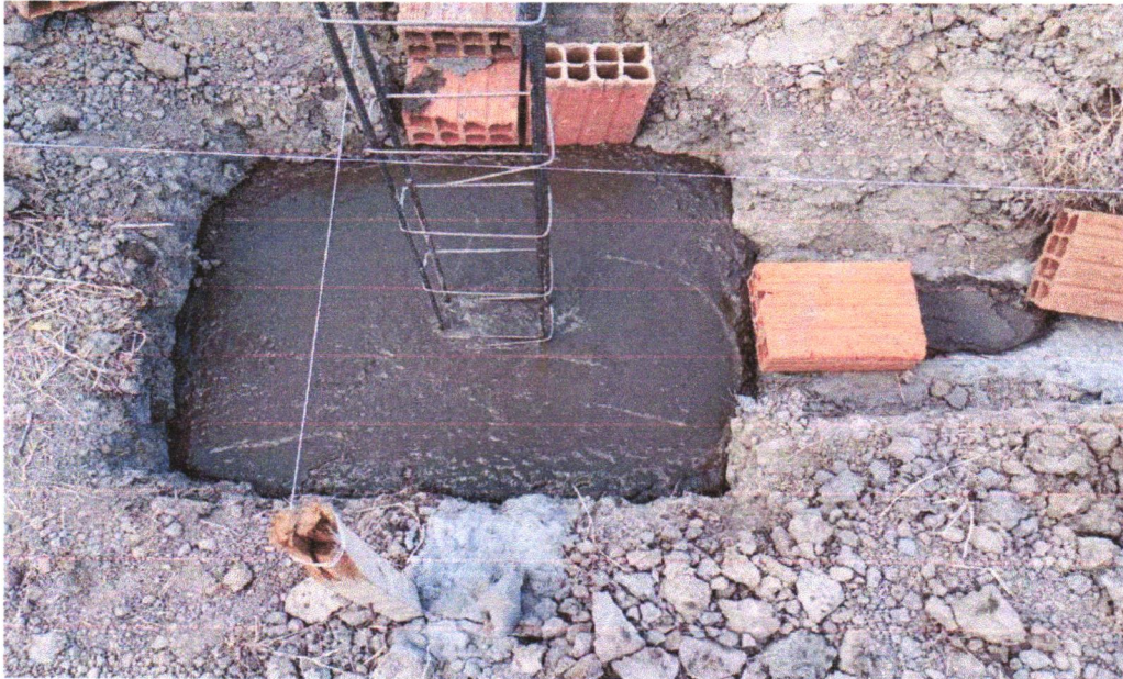
FOTO09 –COMPOSIÇÃO REPRESENTATIVA) EXECUÇÃO DE ESTRUTURAS DE CONCRETO ARMADO, PARA EDIFICAÇÃO HABITACIONAL UNIFAMILIAR TÉRREA (CASA EM EMPREENDIMENTOS), FCK = 25 MPA. AF_01/2017
